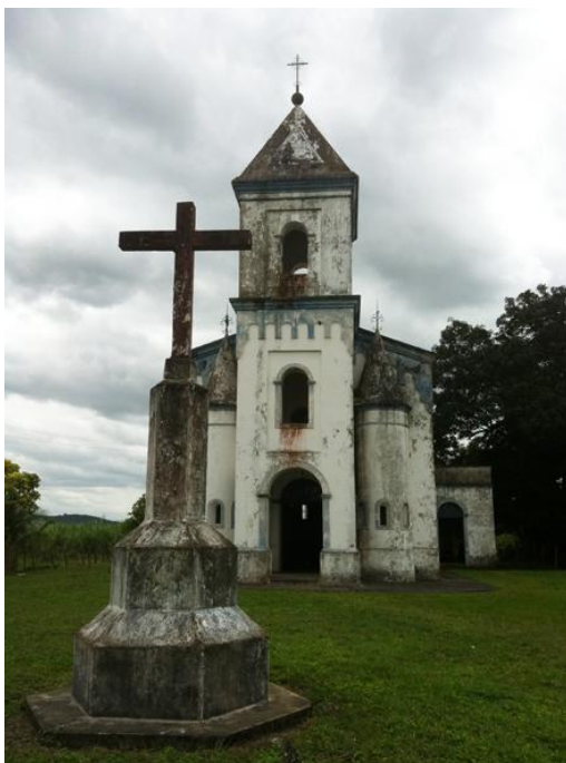
Figura 46 – Fachada da Capela do Engenho Novo de Santo Antônio.
