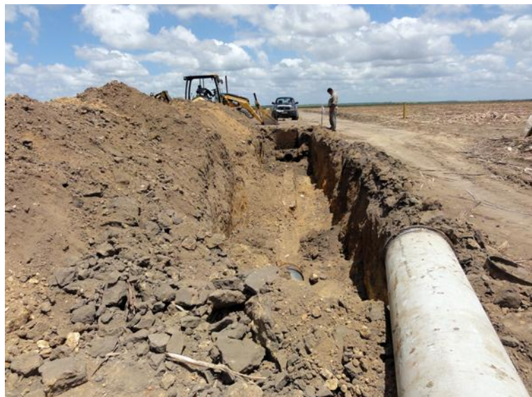
Figura 96 – Abertura de valas para instalação do sistema de irrigação. Foto: Doris Walmsley / Acervo Arqueolog Pesquisas.
