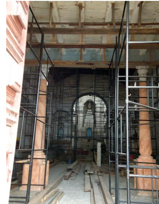
Figura 63 – Obras de restauração do monumento.
