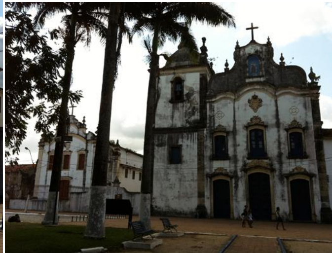
Figura 56 – Igreja da Ordem Terceira (esquerda) ao lado da Igreja e Convento do Carmo (direita).
